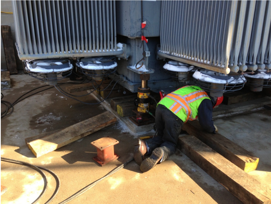
Disconnecting 1R Transformer
