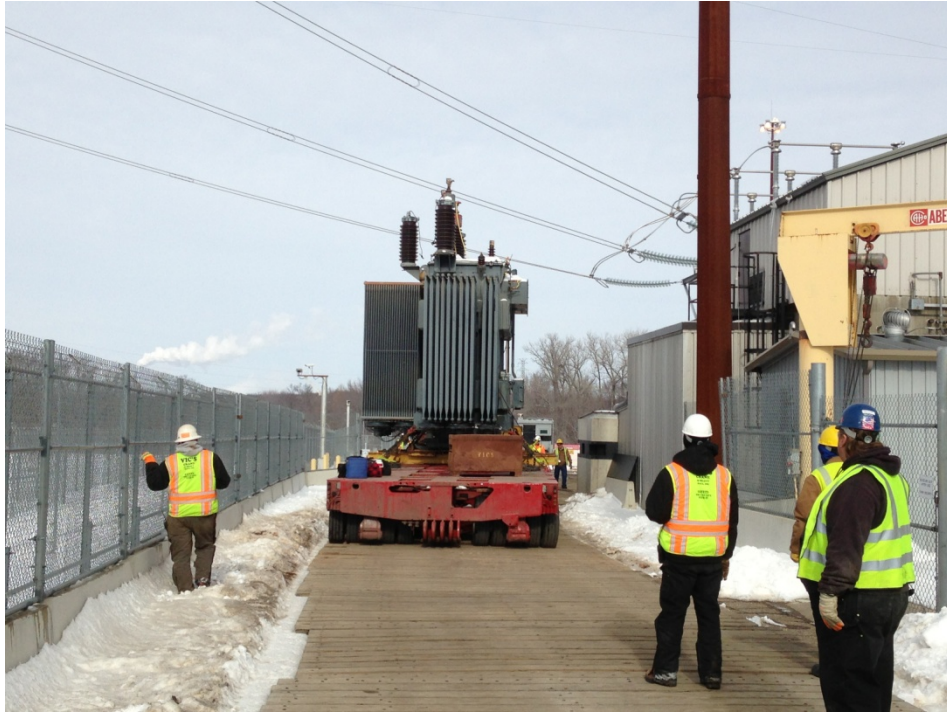
Hauling Existing 1R Transformer
