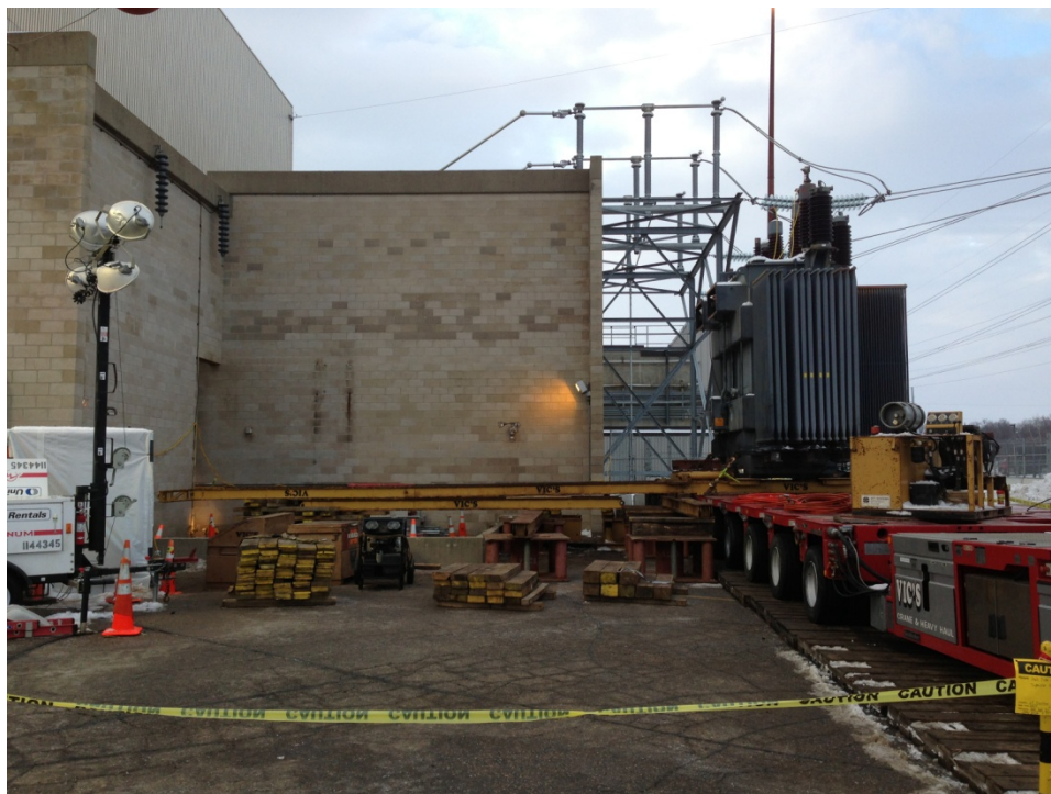
Loading Existing 1R Transformer
